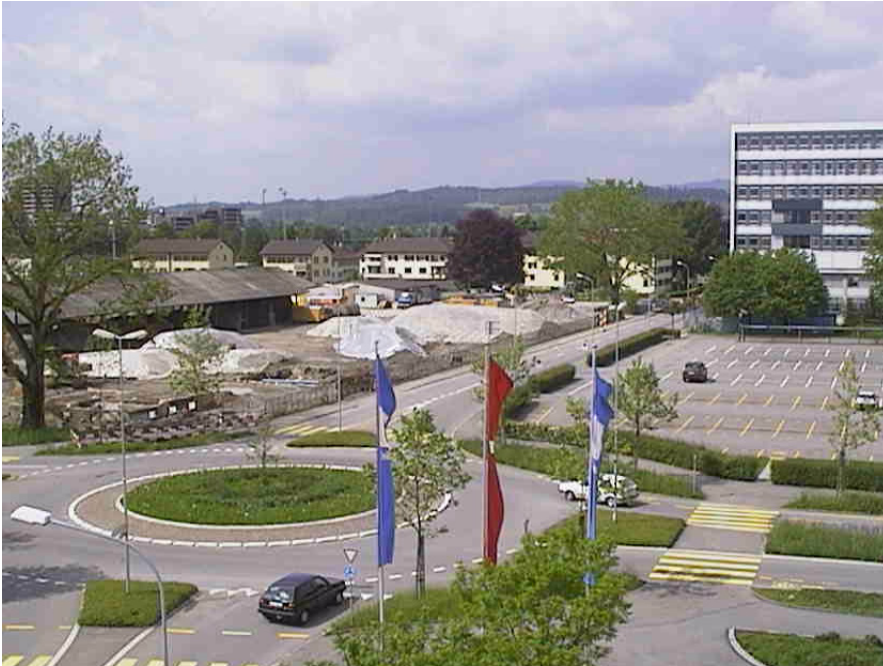
Gasareal im Rückbau, Ansicht aus südlicher Richtung
