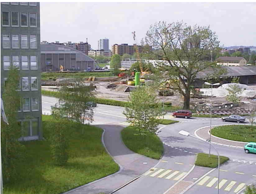
Gasareal im Rückbau, Ansicht aus südöstlicher Richtung
