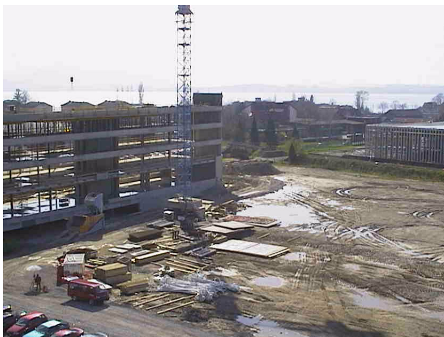
Rohbau, Ansicht vom Kran
