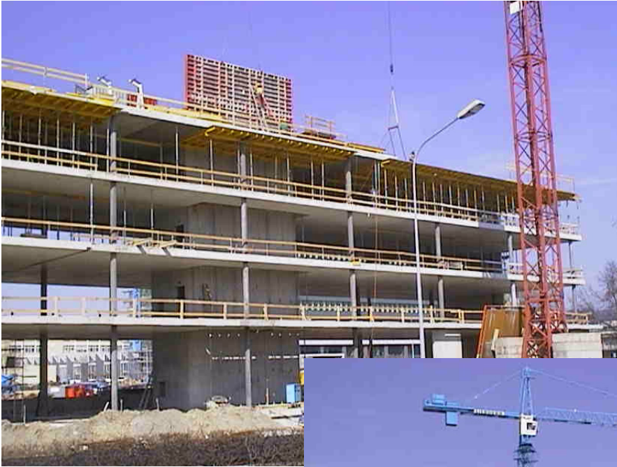
Kaufmännisches Bildungszentrum Zug im Rohbau, Jahr 2000
