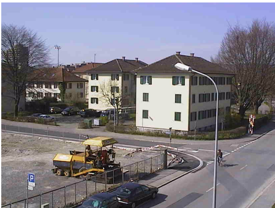
Weststrasse 2 (vorne rechts), Weststrasse 4 (Mitte), Hertistrasse 4 (links), Ansicht aus südöstlicher Richtung
